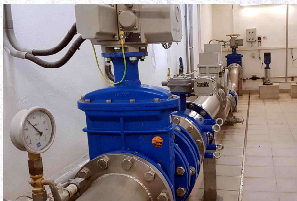
Oprava technologického zařízení PO Poteč
