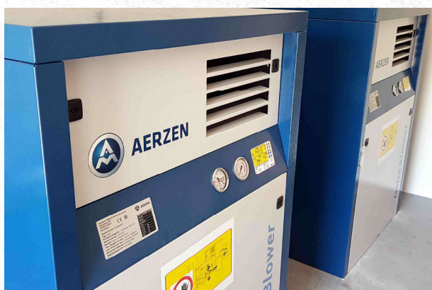
Oprava dmýchárny ČOV Zašová
