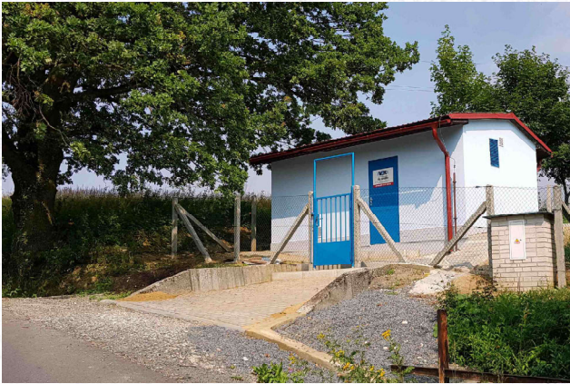
Oprava fasády VDJ Branky
