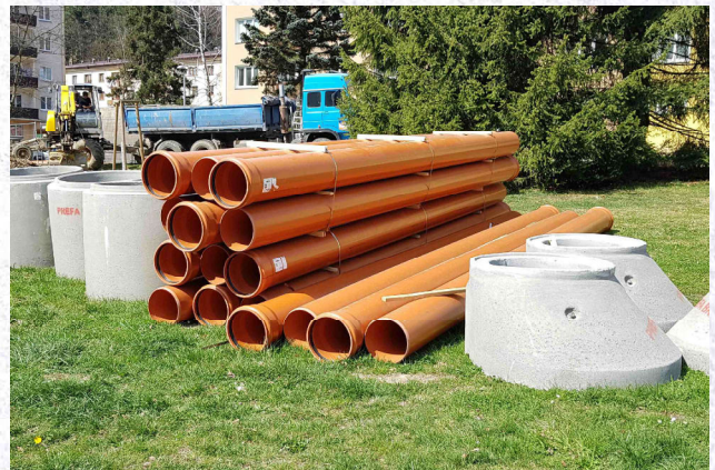
Oprava kanalizace Luh, Vsetín
