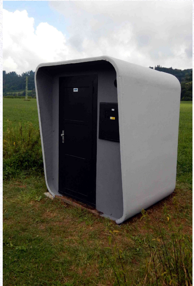
Oprava stanice katodické ochrany Huslenky
