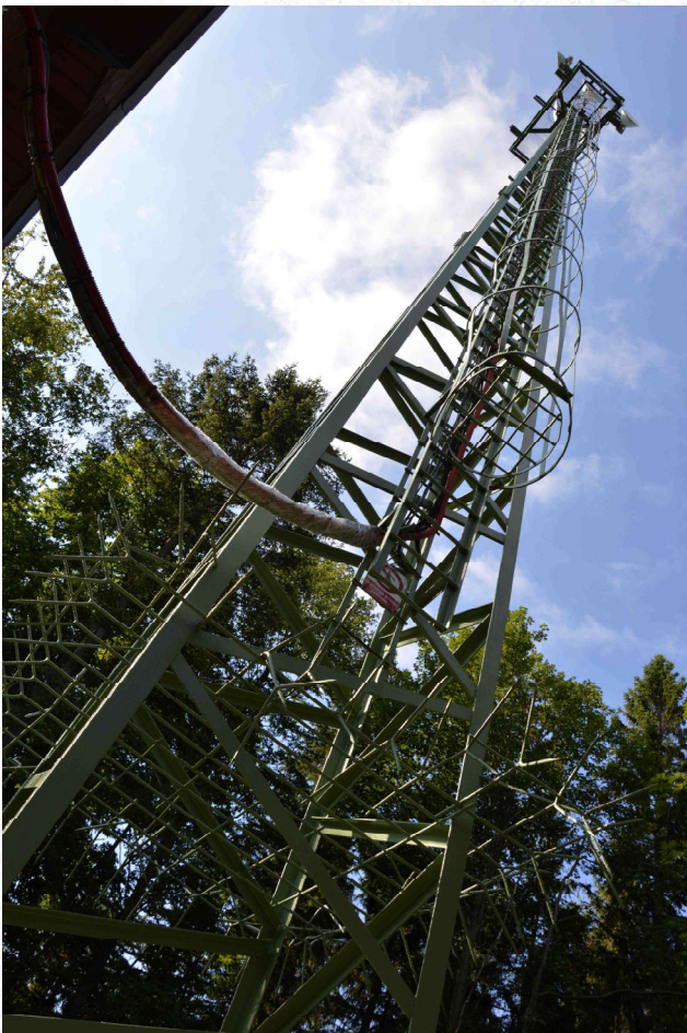
Nátěr stožáru (24 m) retranslační stanice Filka
