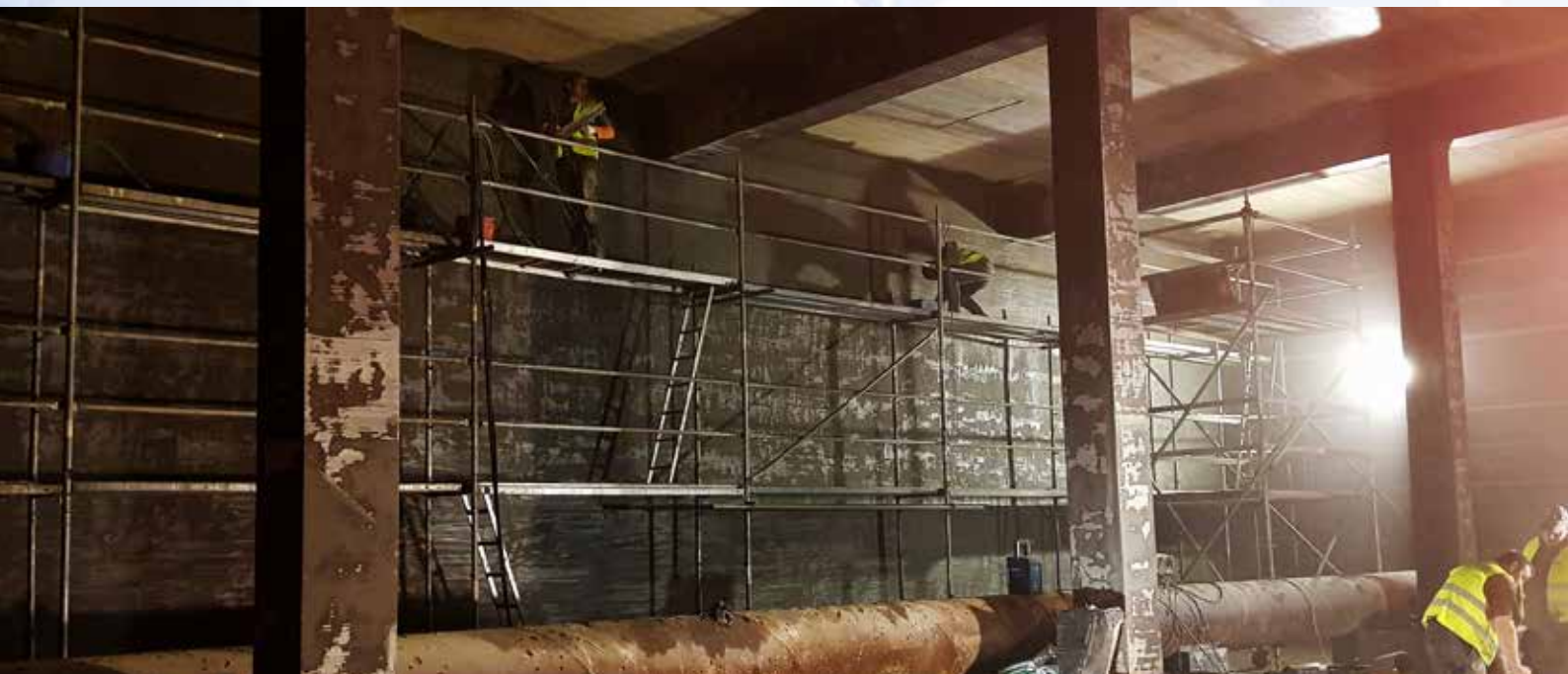
Sanace akumuláční komory VDJ Sychrov HTP
