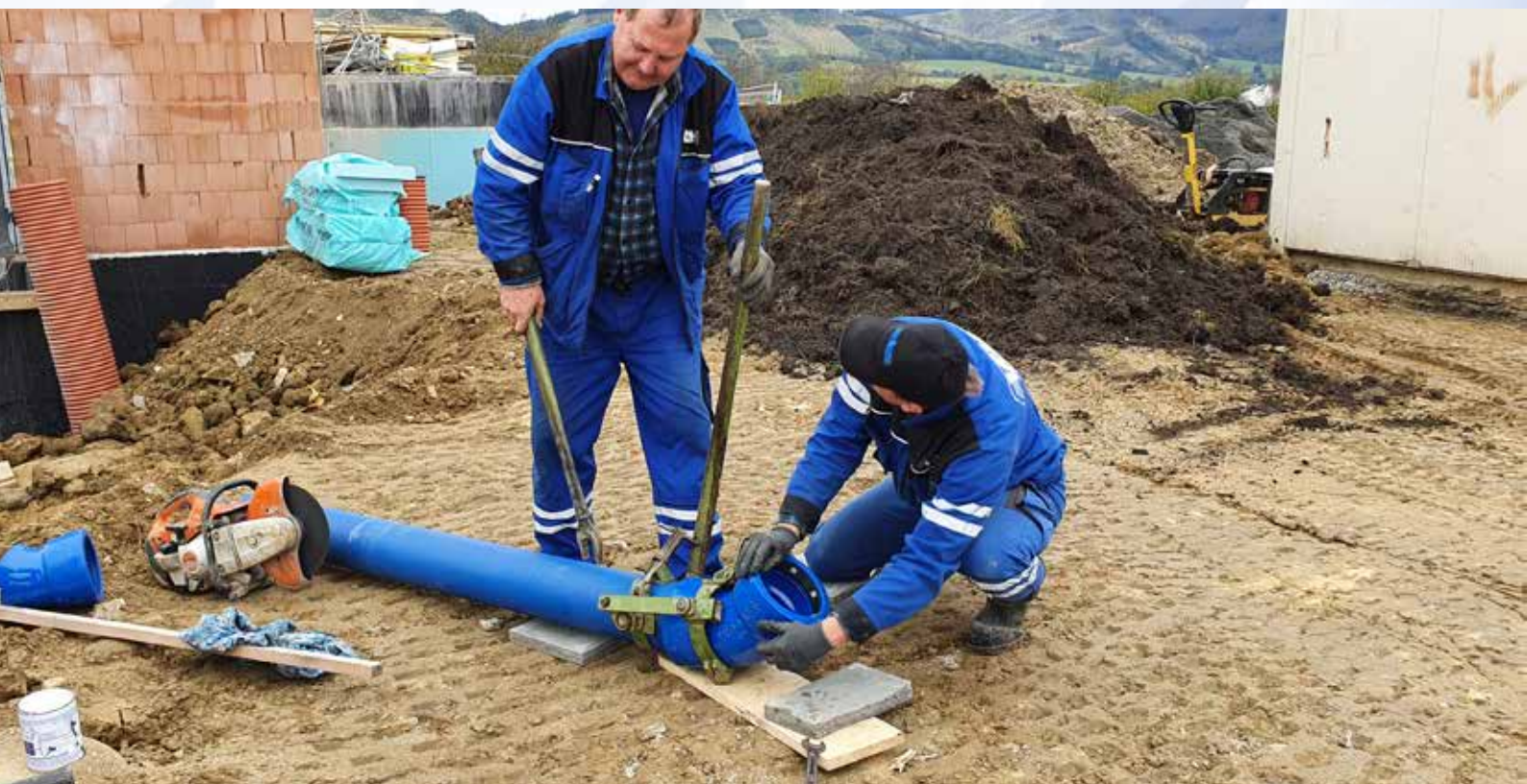
Montážní práce na VDJ+ATS Kunovice
