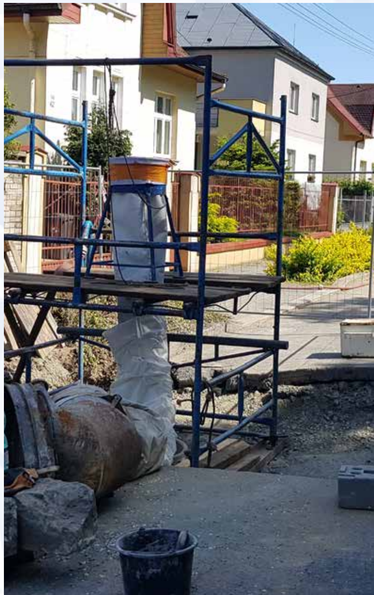
Oprava kanalizace vložkováním Val. Meziříčí ul. Zámecká
