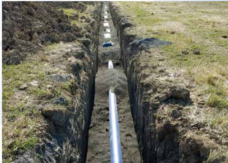
Prodloužení vodovodu Lešná PZ
