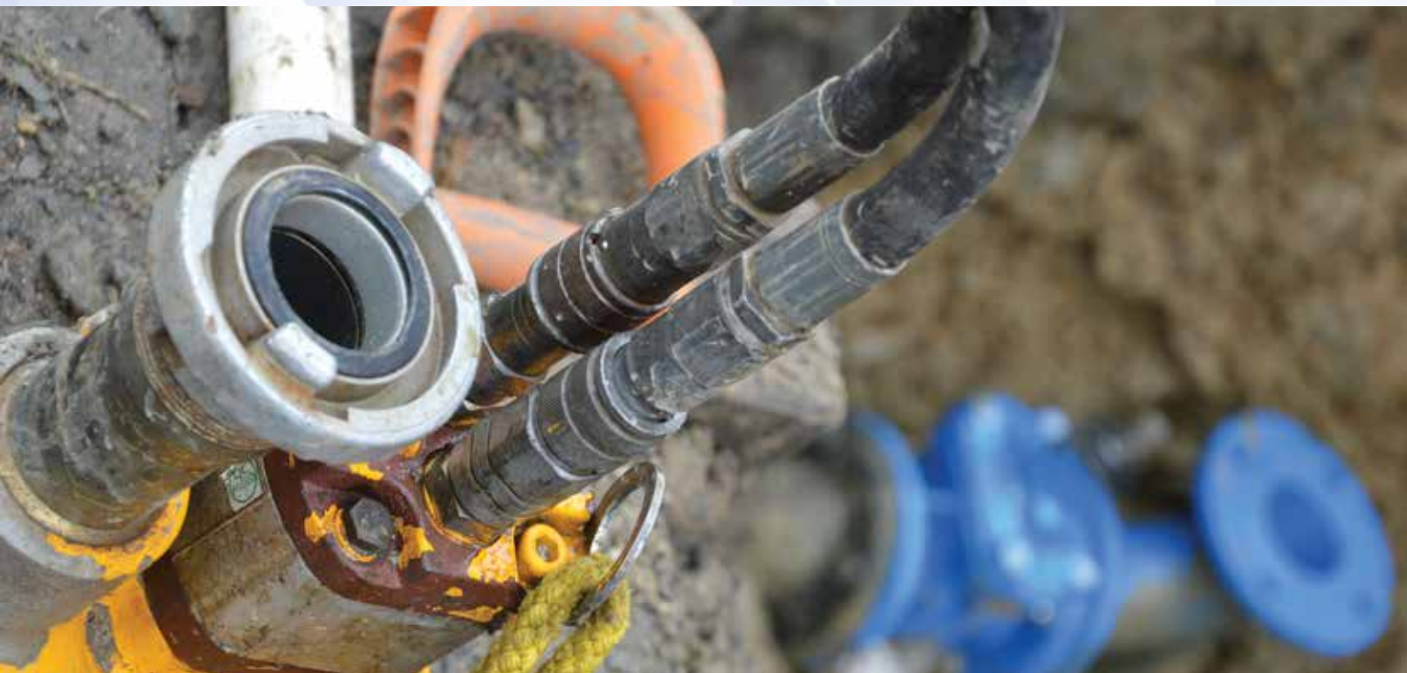
Oprava poruchy na vodovodu ulice Okružní Vsetín
