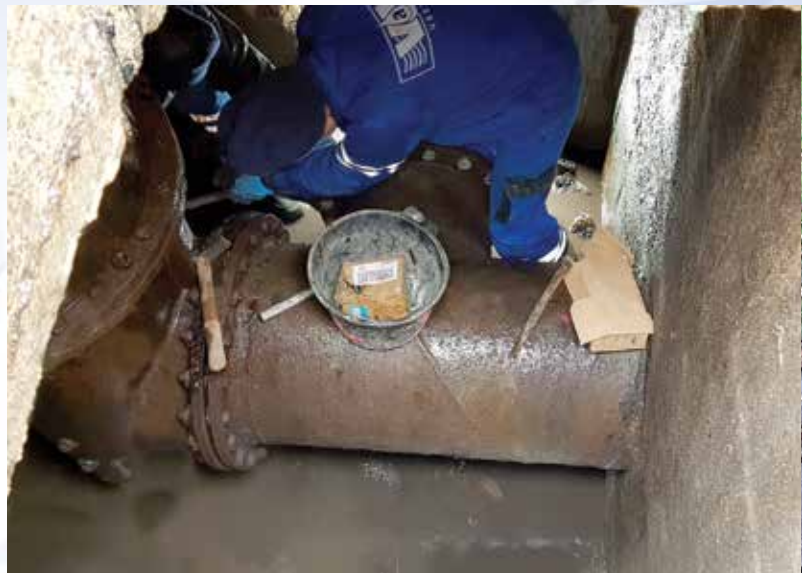
Oprava poruchy Vsetín - Ohrada
