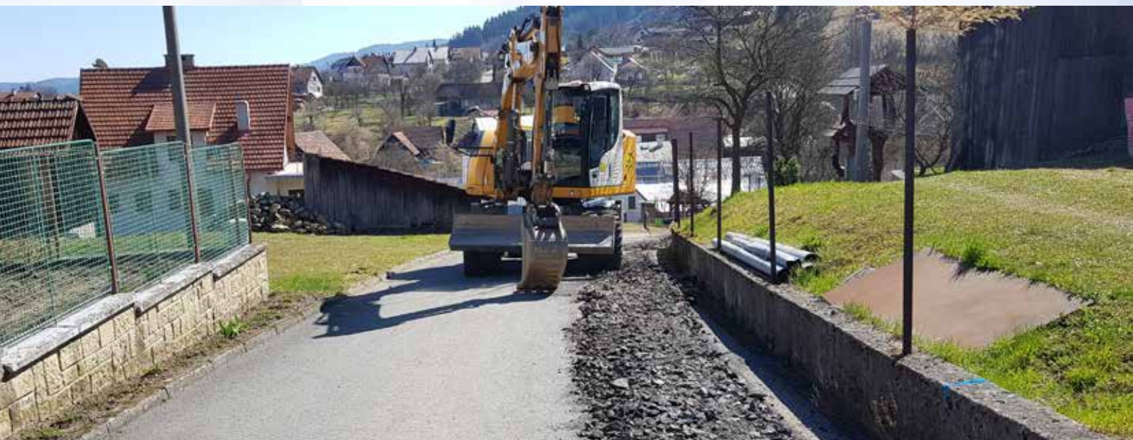
Výměna a přeložka vodovodu Hovězí - pod Kaštýlem
