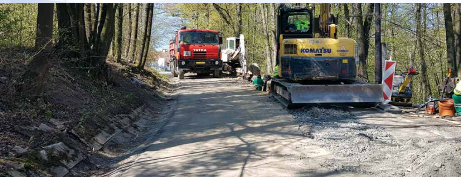
Oprava kanalizace u Sokolovny Rožnov p. R.
