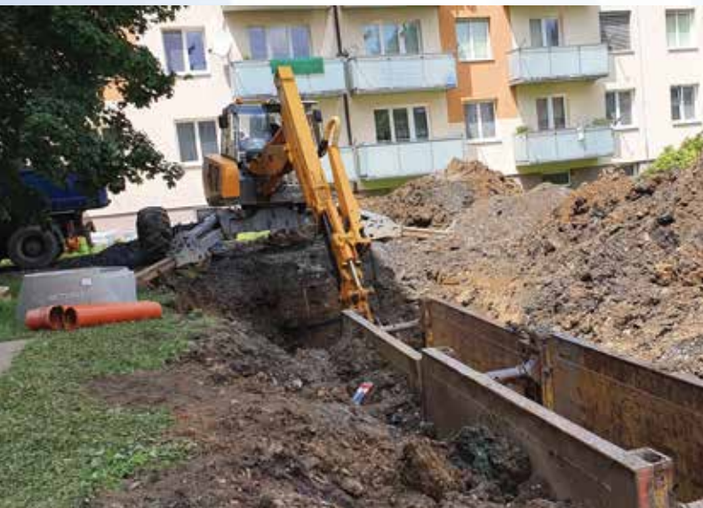
Oprava kanalizace Vsetín - Rybníky
