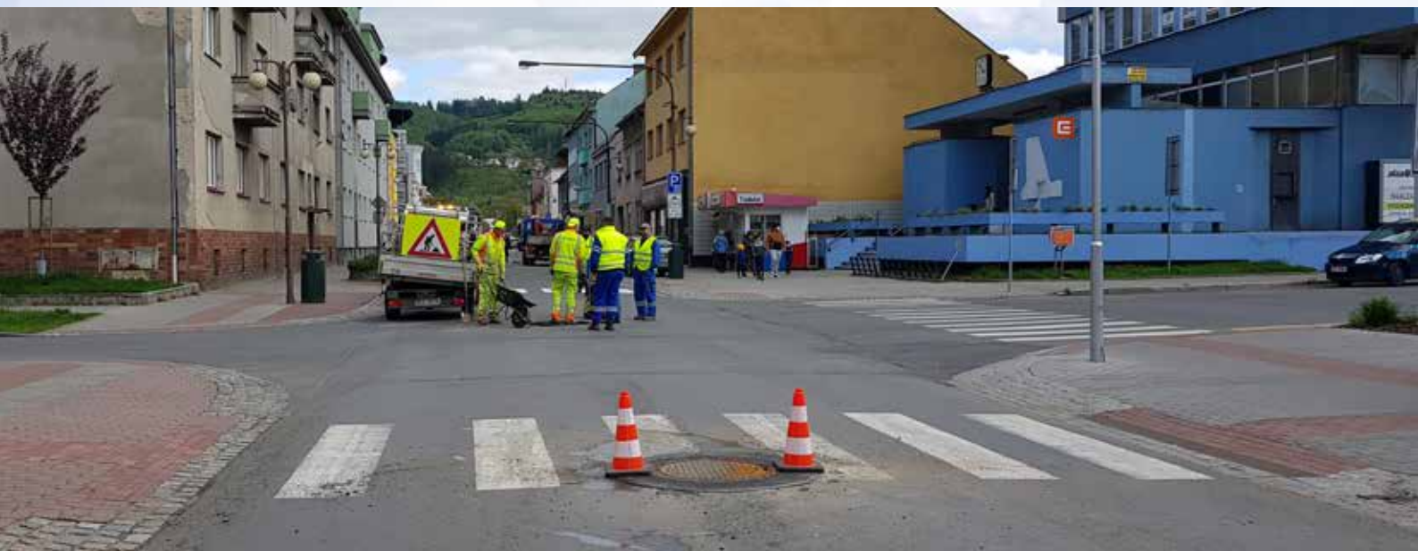
Oprava poklopů Vsetín ul. Smetanova
