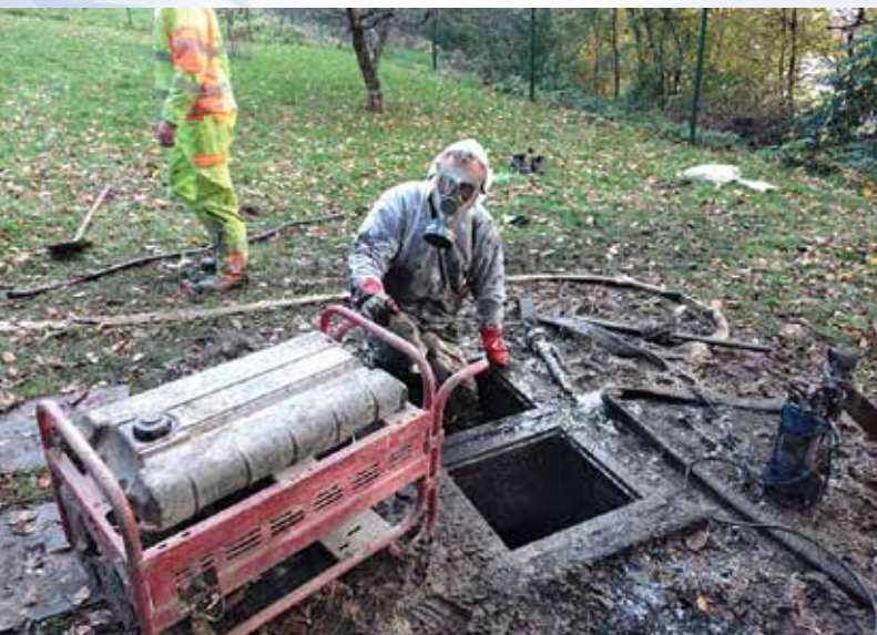
Oprava kanalizace Vsetín - Hrbová
