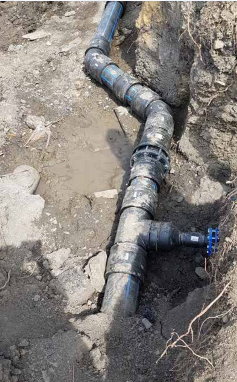
Prívodní řad Rožnov - Zubří, výměna vodovodního potrubí
