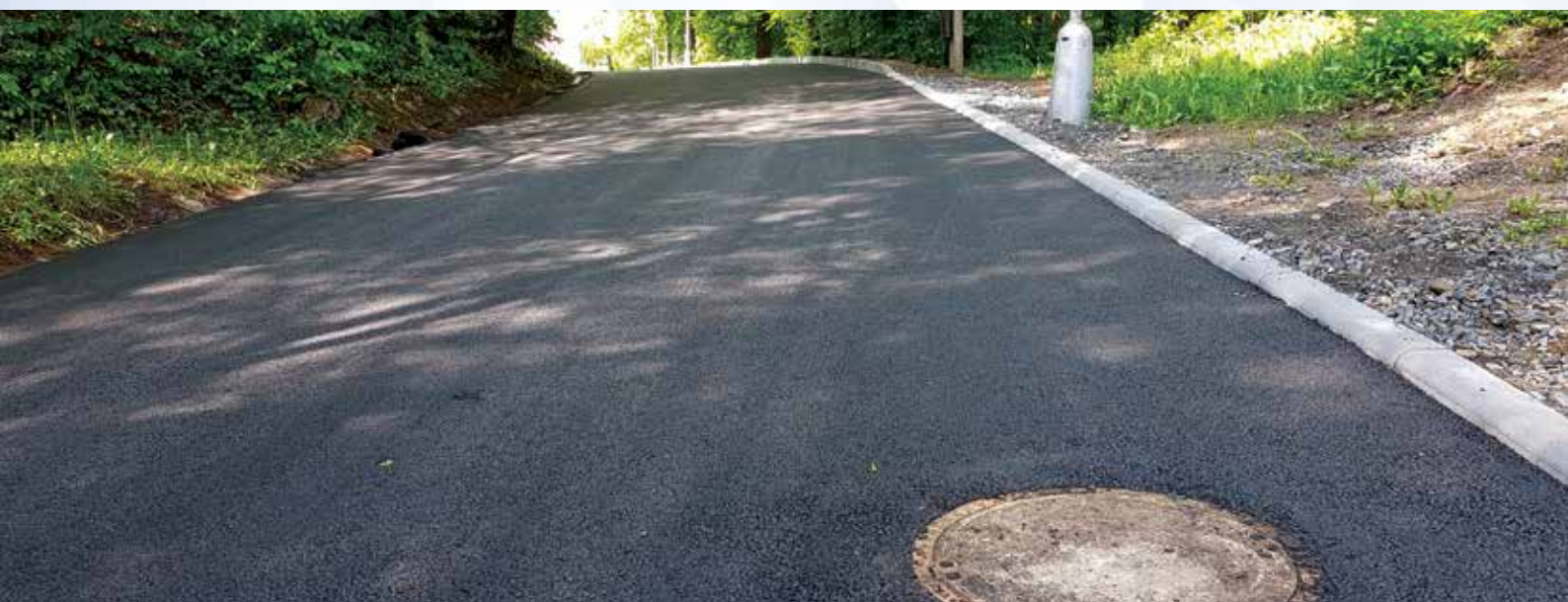
Dokončení opravy kanalizace u Sokolovny Rožnov p. R.
