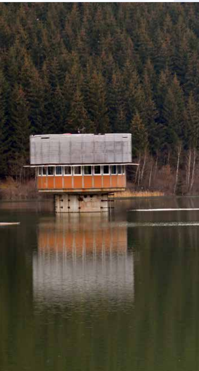
Ovládací věž - přehrada Stanovnice
