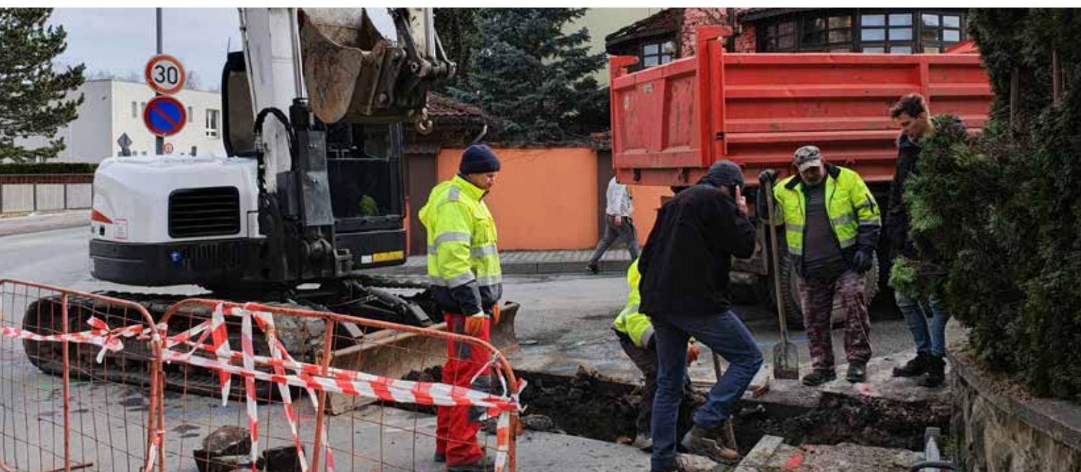
Výměna vodovodu Rožnov p. R. ul. Čechova
