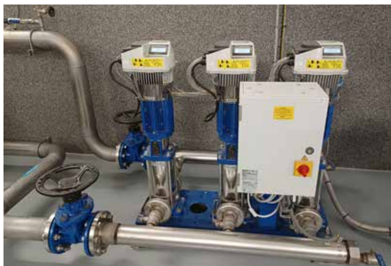
VDJ Štěpánov HTP - automatická tlaková stanice
