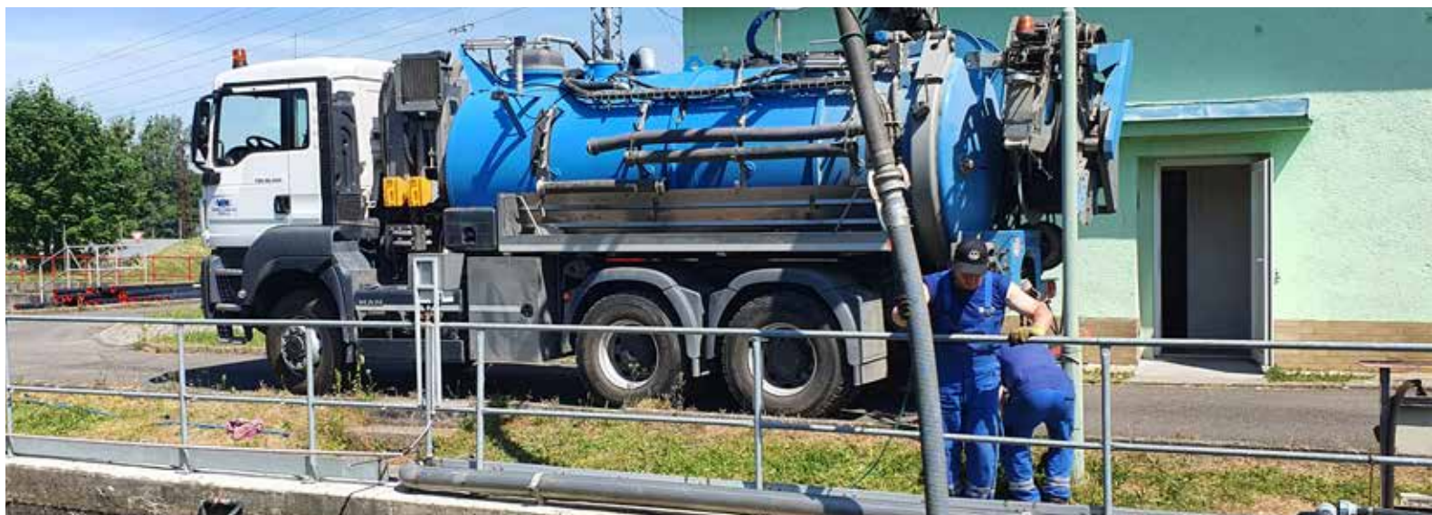
ČOV Zašová - revize aktivační nádrže
