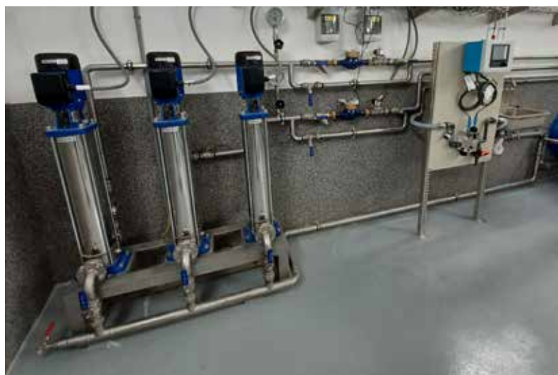
VDJ Štěpánov HTP - dávkování a měření chlorňanu
