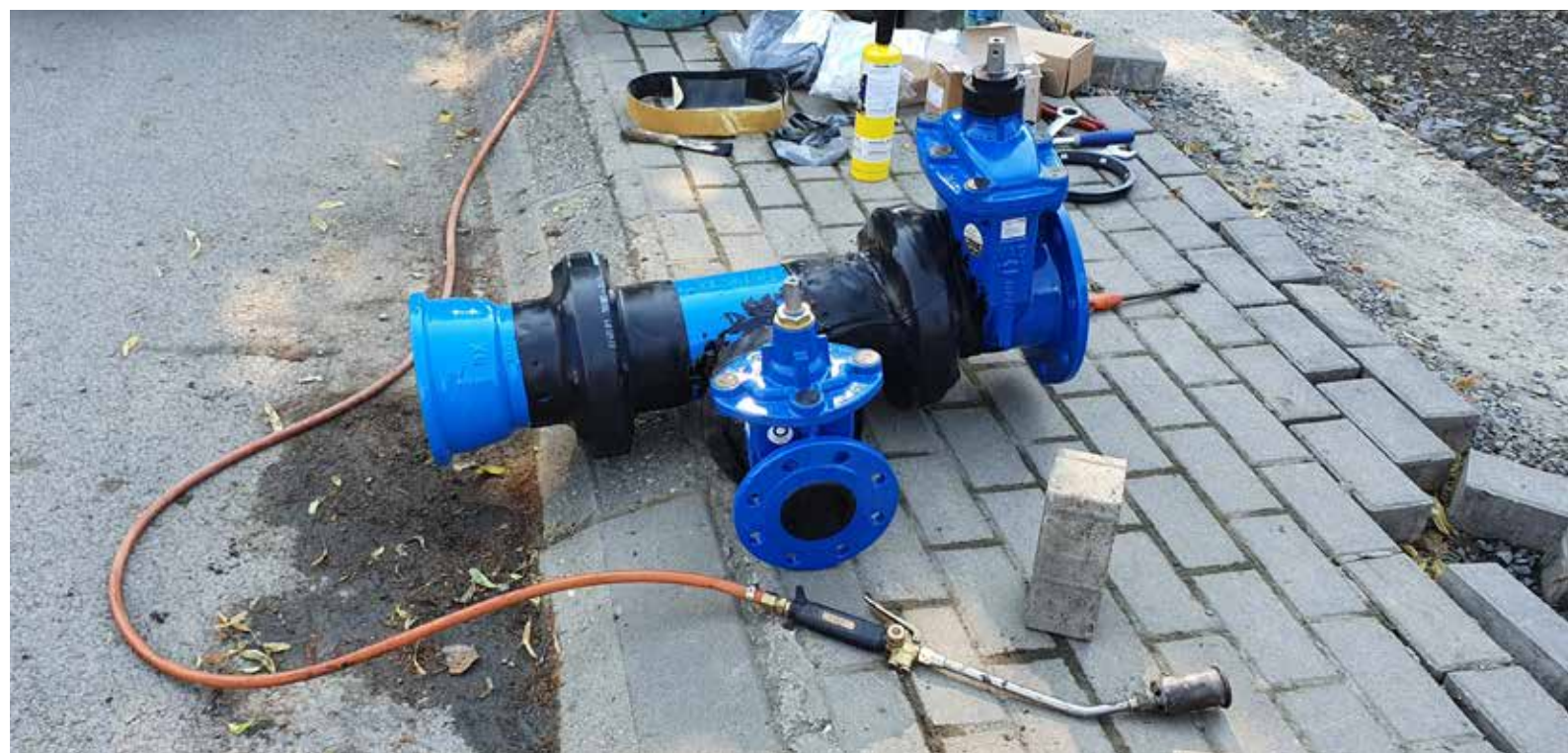
Oprava vodovodu na ul. Hranická, Valašské Meziříčí
