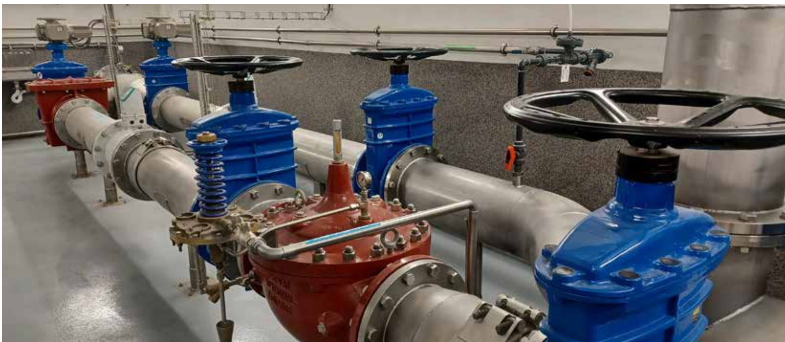
VDJ Štěpánov HTP - nově vystrojená armaturní komora
