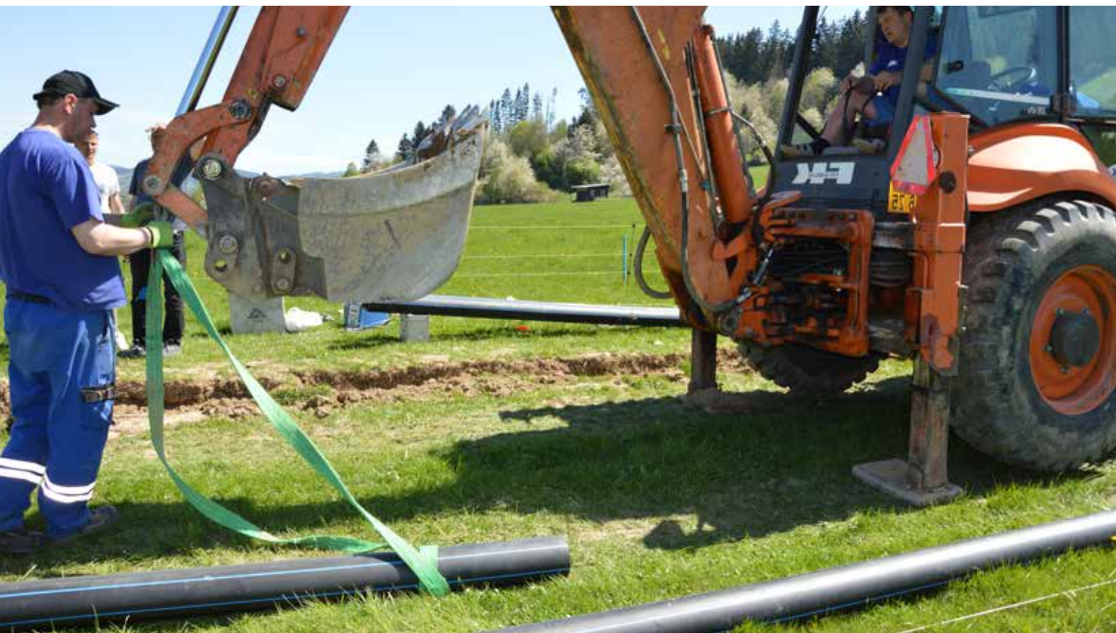
Práce na přívodním řadu do VDJ Halenkov
