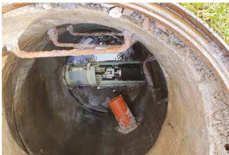
Vložkování kanalizací
