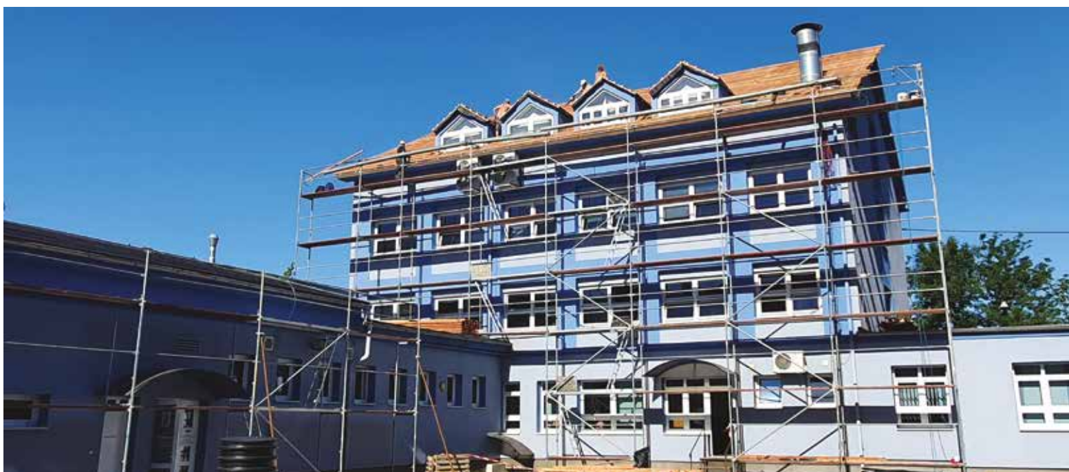
Správní budova Vsetín - oprava střechy
