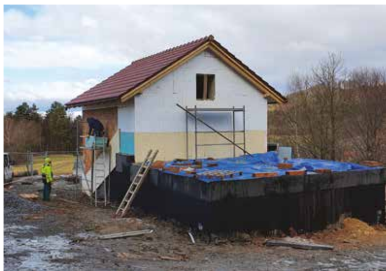
Výstavba vodojemu Zašová
