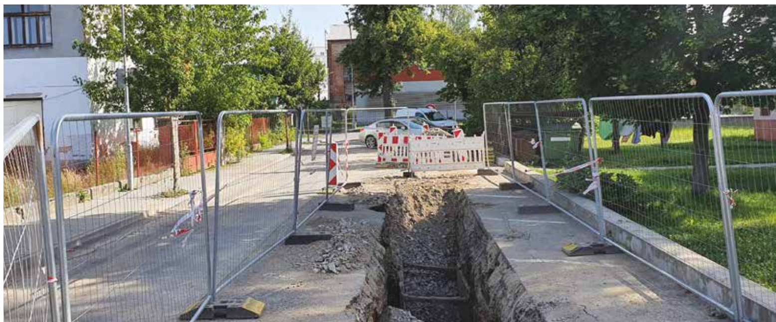
Oprava kanalizace Valašské Meziříčí, ul. Schlattauerova
