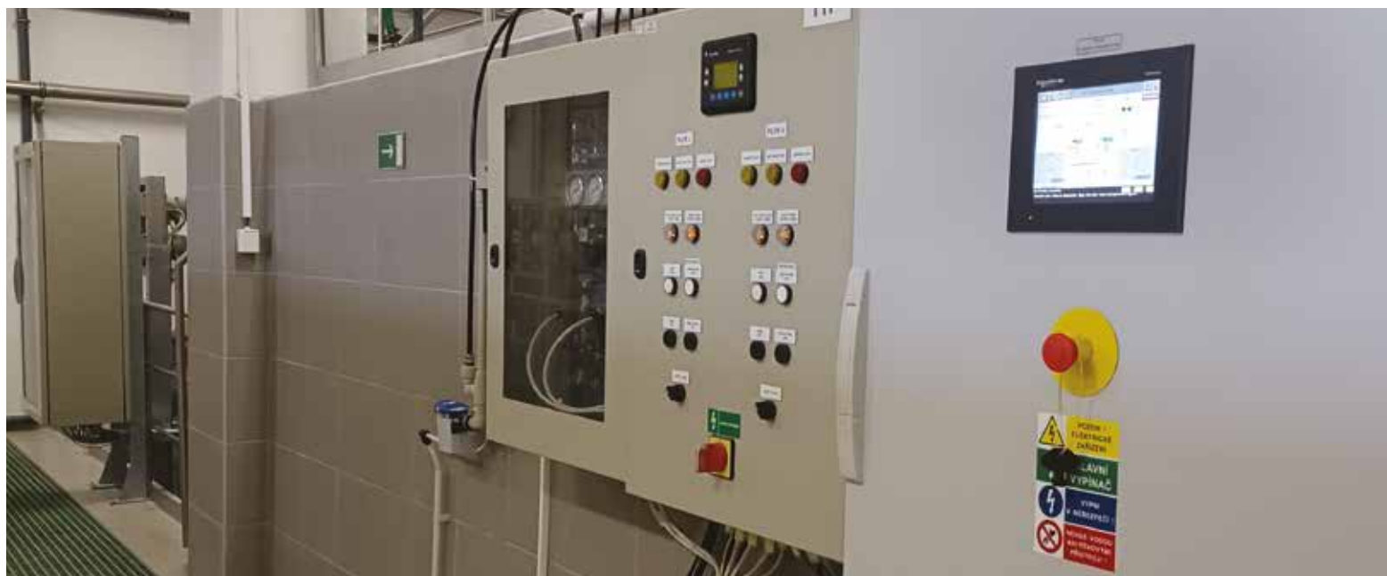
Oprava řídicího systému ÚV Rožnov pod Radhoštěm
