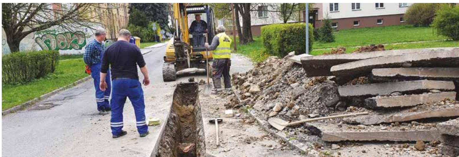
Výměna vodovodu Vsetín, Rybníky III. etapa
