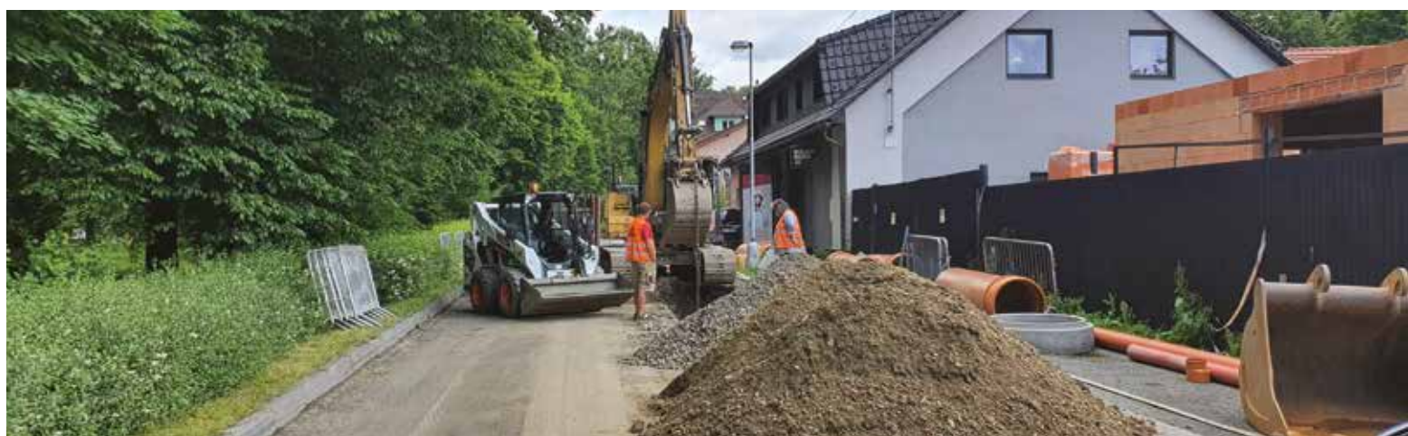
Oprava kanalizace Rožnov pR, ul. Pionýrská
