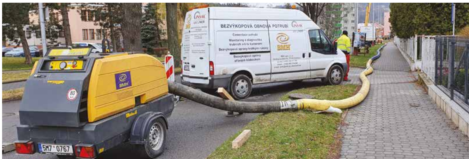
Vložkování kanalizace Vsetín, ul. Jiráskova
