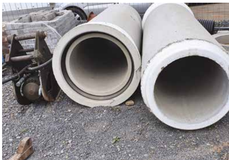
Materiál na přeložku kanalizace v Zašové
