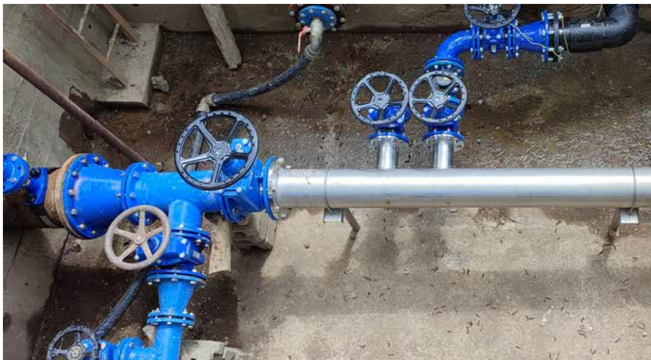
Rekonstrukce rozdělovací šachty Rožnov pod Radhoštěm - Skanzen
