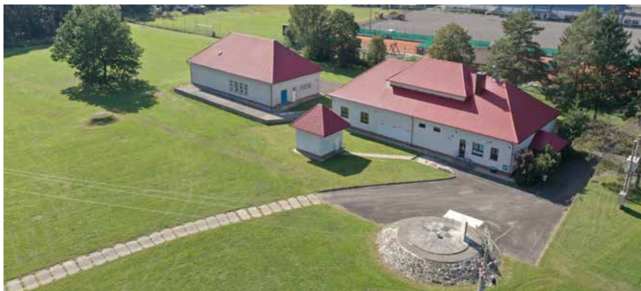
Úpravná vody Rožnov pod Radhoštěm
