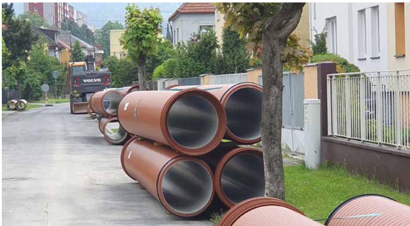
Vložkování kanalizace Valašské Meziříčí, ulice Fügnerova
