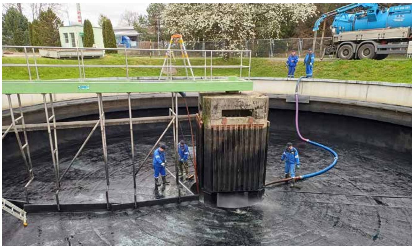
Čištění dosazovací nádrže na čistírně odpadních vod Valašské Meziříčí
