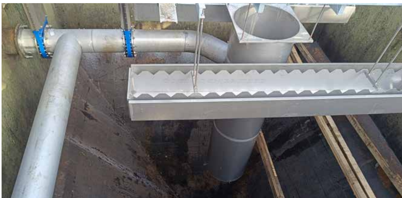
Čistírna odpadních vod Halenkov - oprava dosazovací nádrže
