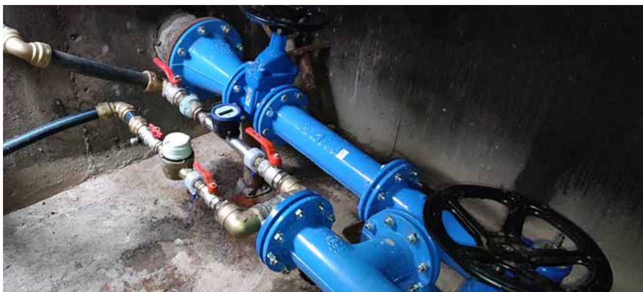
Přestrojování vodoměrné a rozbočovací šachty - Rožnov pod Radhoštěm
