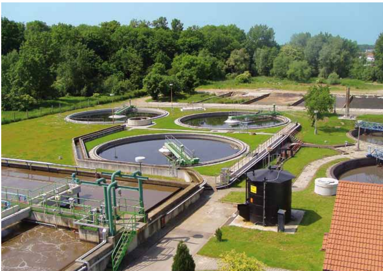
ČOV Valašské Meziříčí
