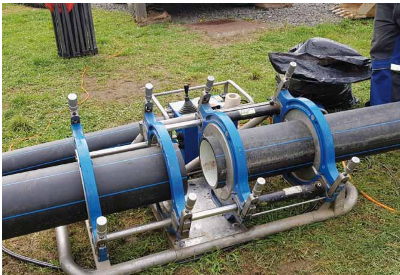
Spojování PE vodovodního potrubí
