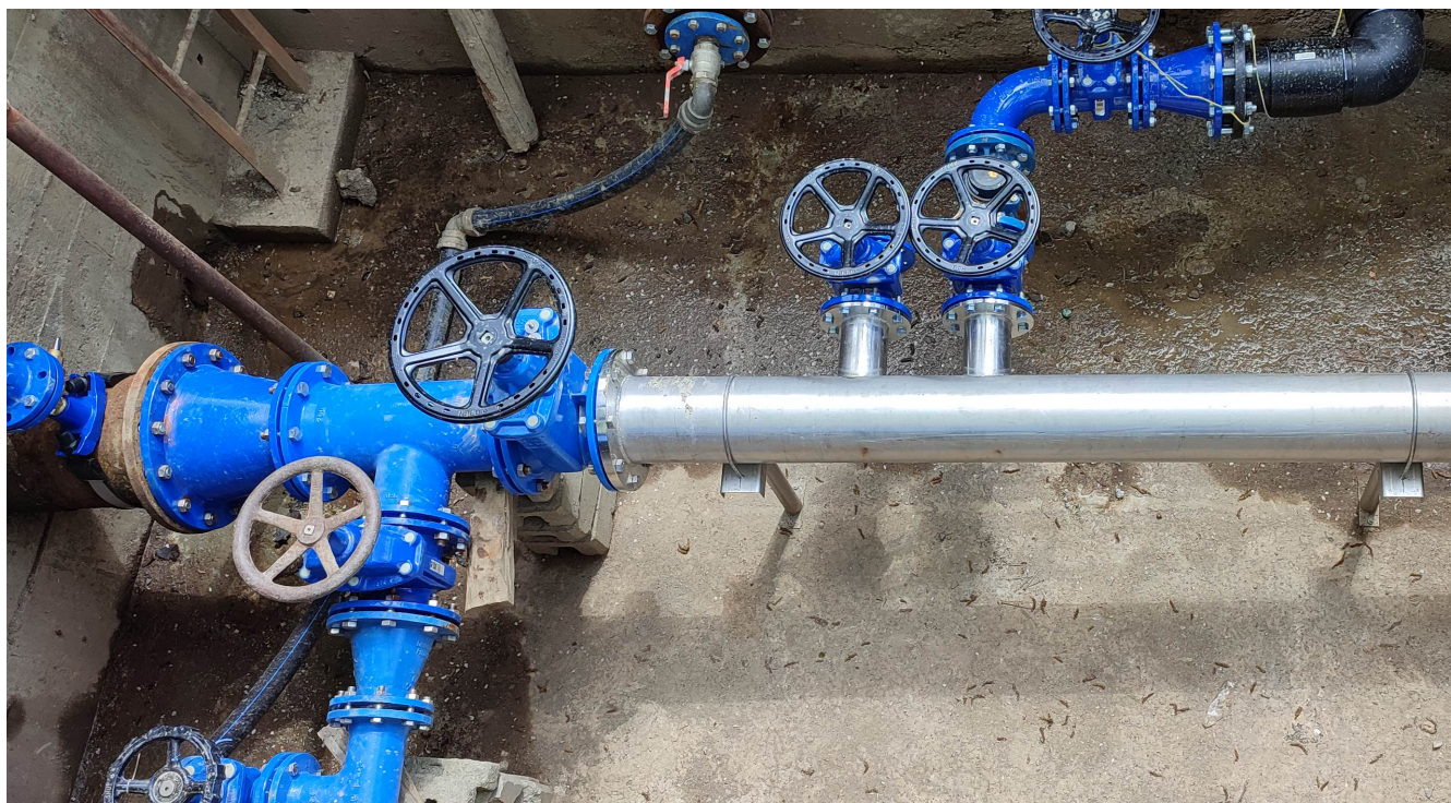
Rekonstrukce rozdělovací šachty Rožnov pod Radhoštěm - Skanzen
