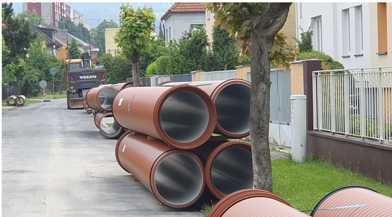
Vložkování kanalizace Valašské Meziříčí, ulice Fügnerova
