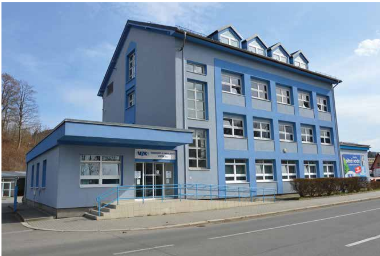
Správní budova společnosti, Jasenická 1106, 755 01 Vsetín
