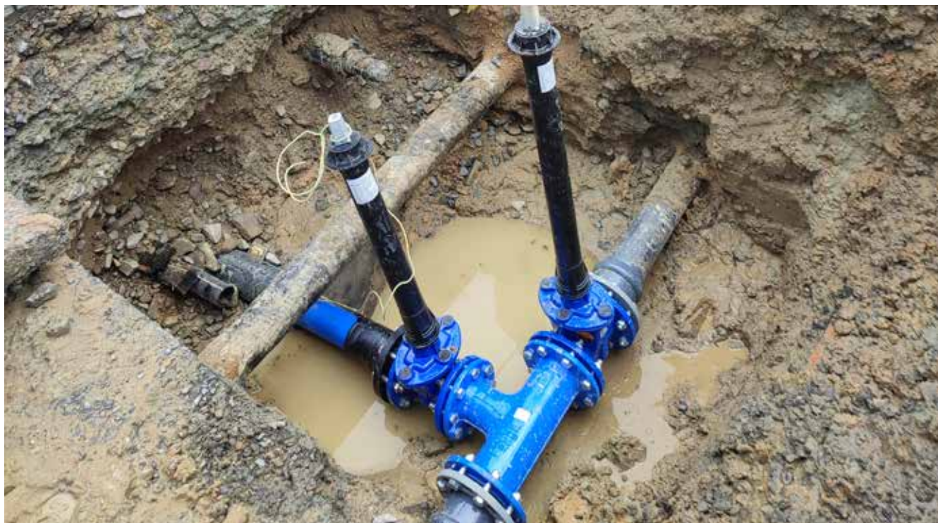
Odbočení pro nový vodovodní veřejný řad - Zubří, ul. Rožnovská
