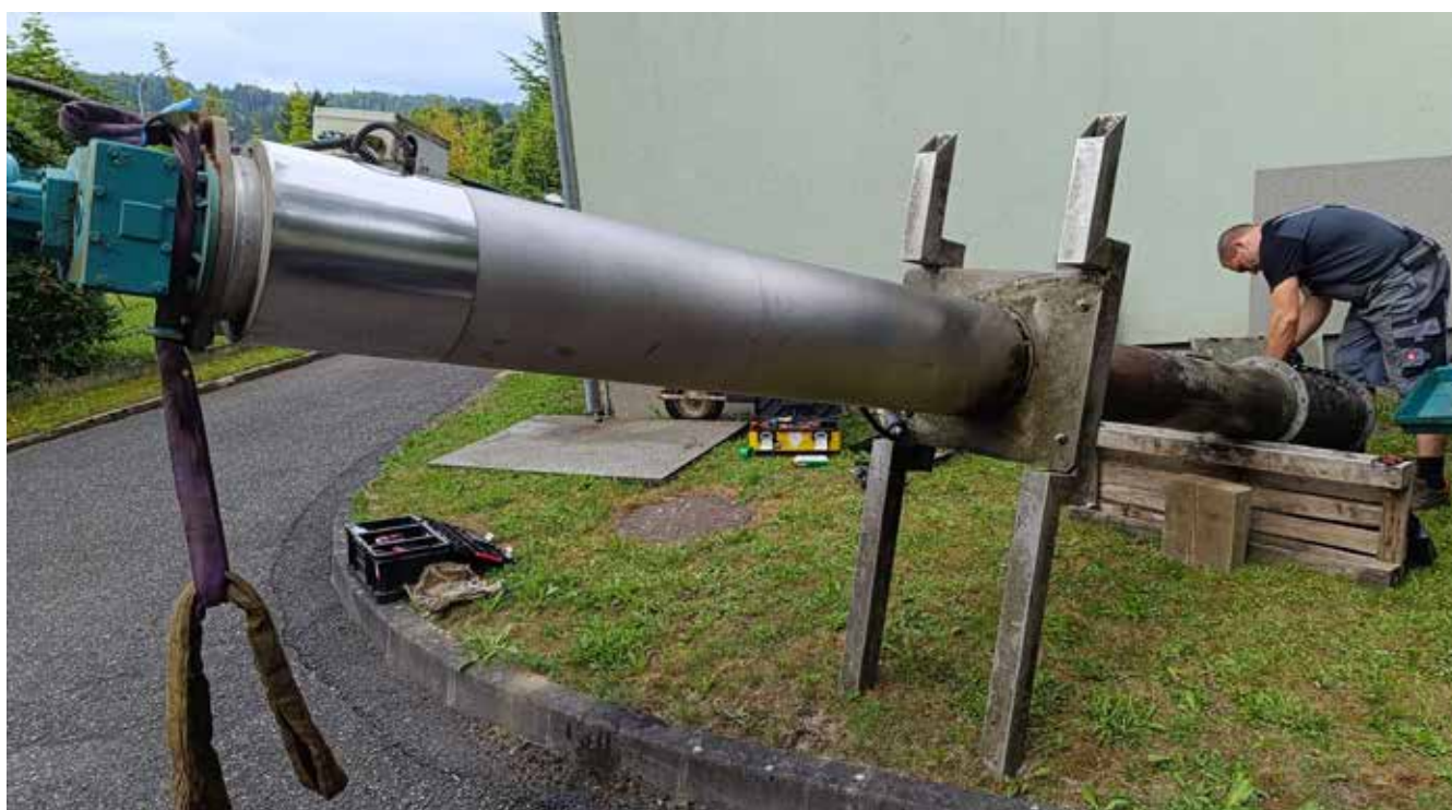
Čistírna odpadních vod Velké Karlovice - čištění česle
