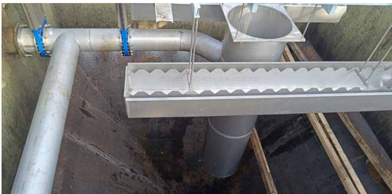
Čistírna odpadních vod Halenkov - oprava dosazovací nádrže
